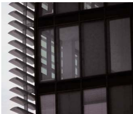
Außenliegender Sonnenschutz wie hier beim Rivergate hält die Hitze draußen, aber nicht alle Bürohäuser haben einen
