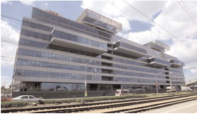
Im Catamaran am Handelskai befindet sich auch die ÖGB-Zentrale. Die markanten Glasboxen am Dach stehen noch frei. Ab Oktober hält die U2 direkt vor dem Gebäude
