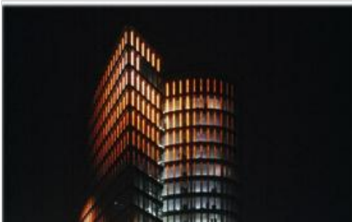
Für den "Energiebewussten Neubau" gab's das Green Building Zertifikat der EU.
