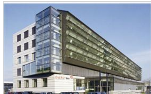
Forschungsobjekt und das erste Büropassivhaus Österreichs im großen Stil.
