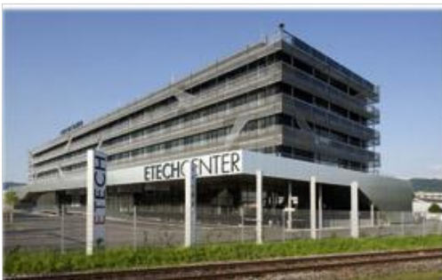
Verkehrsgünstig gelegen, mit einem ausgeklügelten Energiekonzept: Etechcenter Linz.
